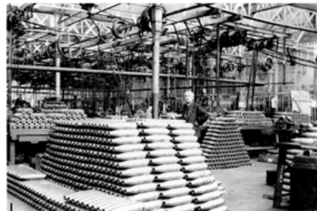
Vue intérieure d'une usine auboise, sans doute Jules Lebocey et C ie , reconvertie pour la fabrication d'obus, s.d. [1915-1918].
